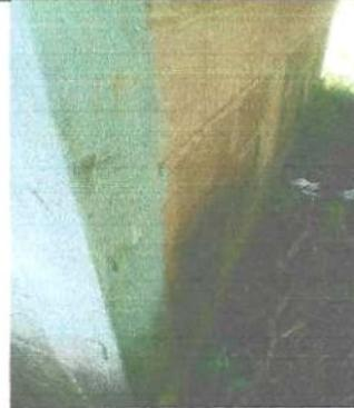
Foto 4: se observa que la pared tiene mucha humedad en la parte de atrás, además tiene mas de 23 años de construcción.
